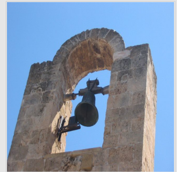
particolare del campanile
